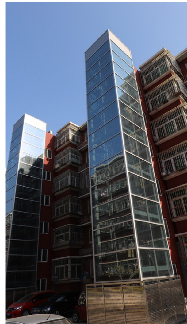
老旧楼宇加装项目
