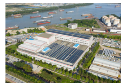
日立能源中山变压器生产园区中的屋顶光伏
